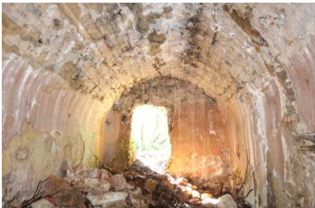
Fig. 31 : Intérieur du bâtiment, vue sur « l'entrée »
