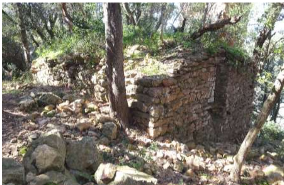
Fig. 19 : Ensemble du bâtiment vu du sud-est
