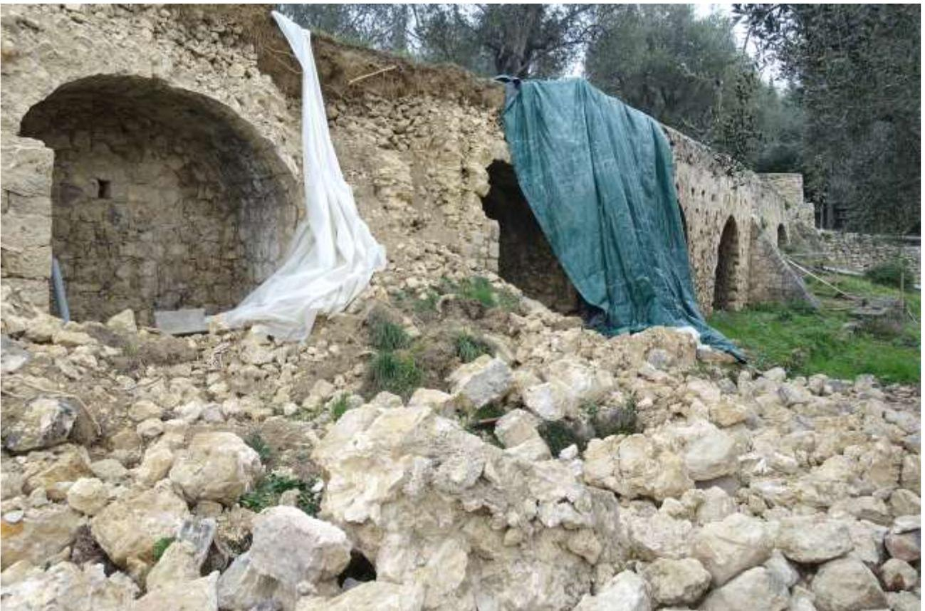
Fig. 39 : Détail de l'effondrement partiel
