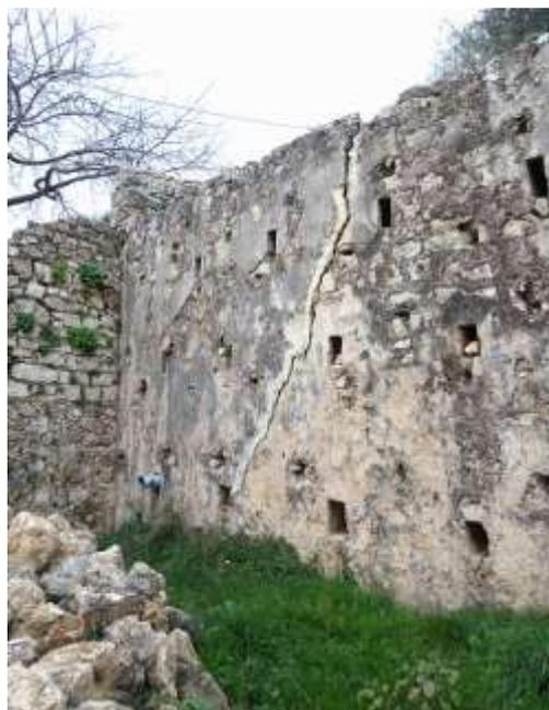
Fig. 35 : Fissure importante (extrémité occidentale)
