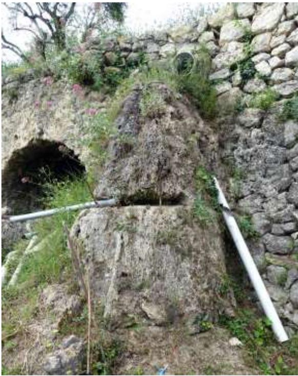
Fig. 51 : Excroissance de tuf calcaire
