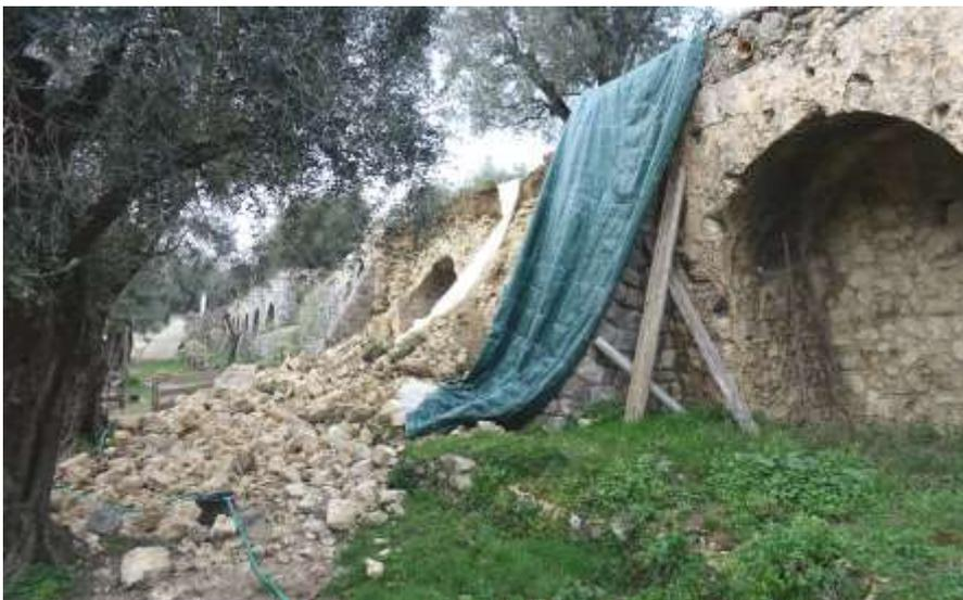
Fig. 15 : Vue d'ensemble de l'écroulement partiel du Grand Mur
