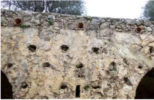
Fig. 43 : Surélévation orientale du Grand Mur avec addition des bouches d'écoulement
