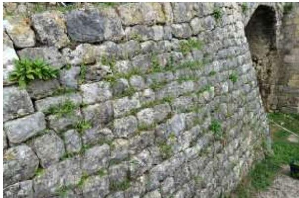
Fig. 58 : Mur intérieur avec fruit
