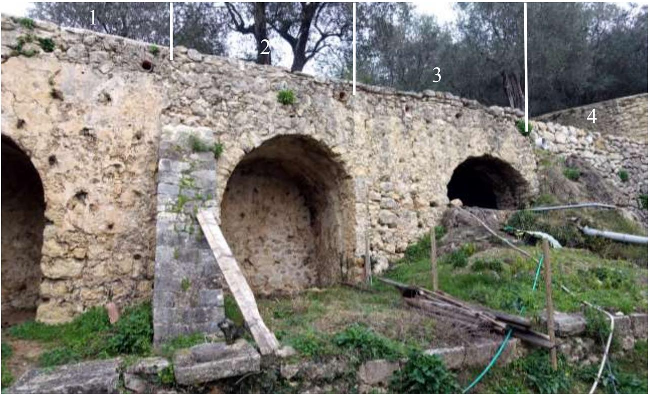
Fig. 36 : Partie orientale montrant trois types de construction et de reconstruction
